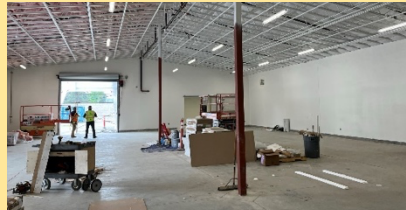
마무리 작업 중인 내부
